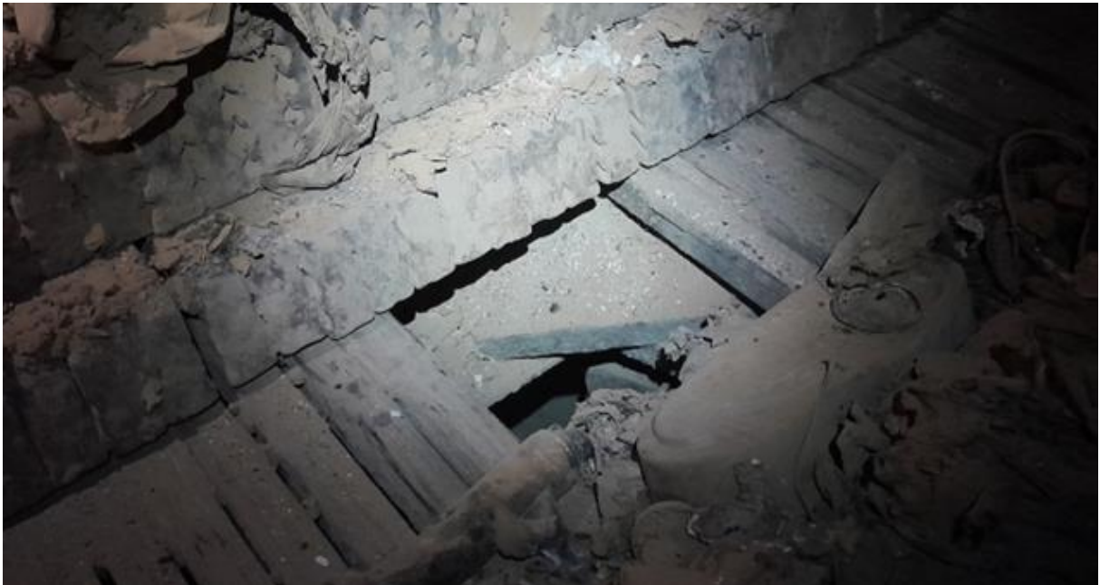
Trou occasionné par l'explosion d'une bouteille de protoxyde d'azote dans le four. Les déchets imbrûlés tombaient alors dans le trou créé.
